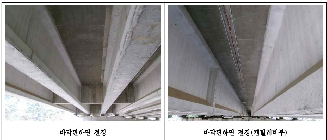
【사진 7.3.2】 바닥판하면 전경
