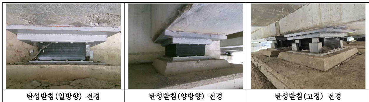
【사진 7.3.12】 교량받침 전경
