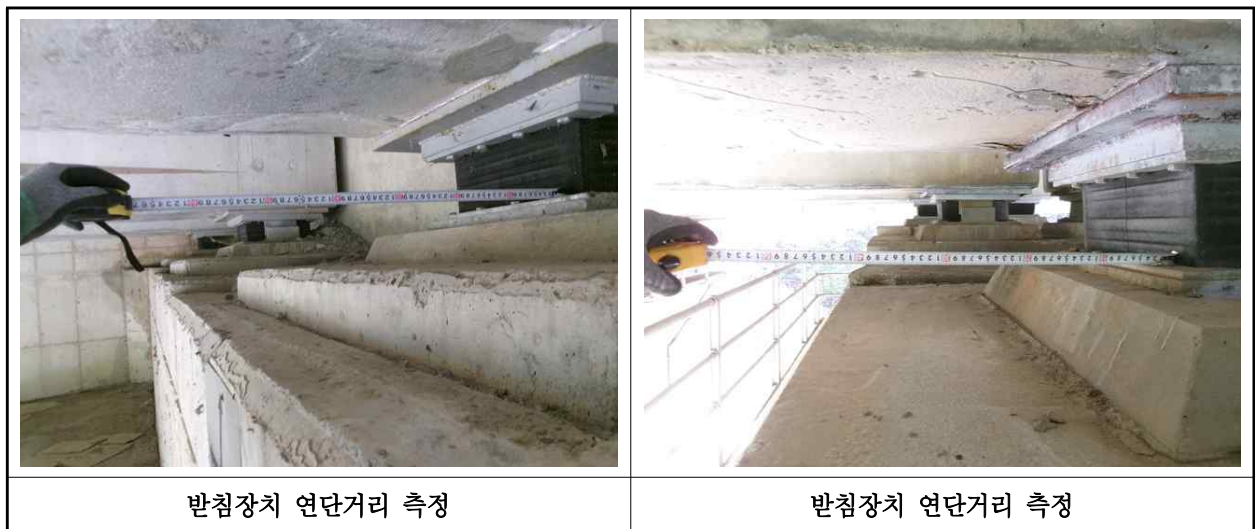
【사진 7.3.14】 교량받침장치 연단거리측정
