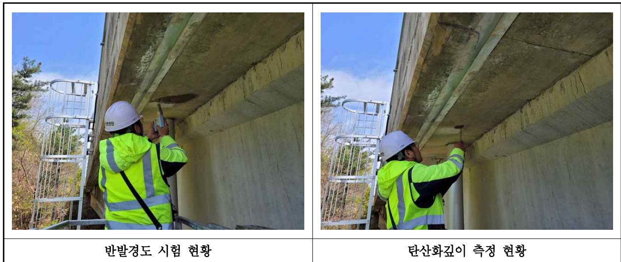
【사진 7.4.1】 콘크리트 내구성조사 현황
