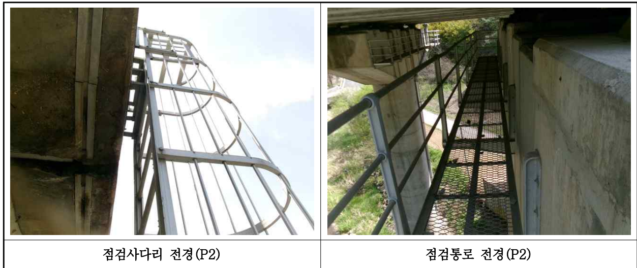
【사진 7.3.25】 교량 점검시설 전경
