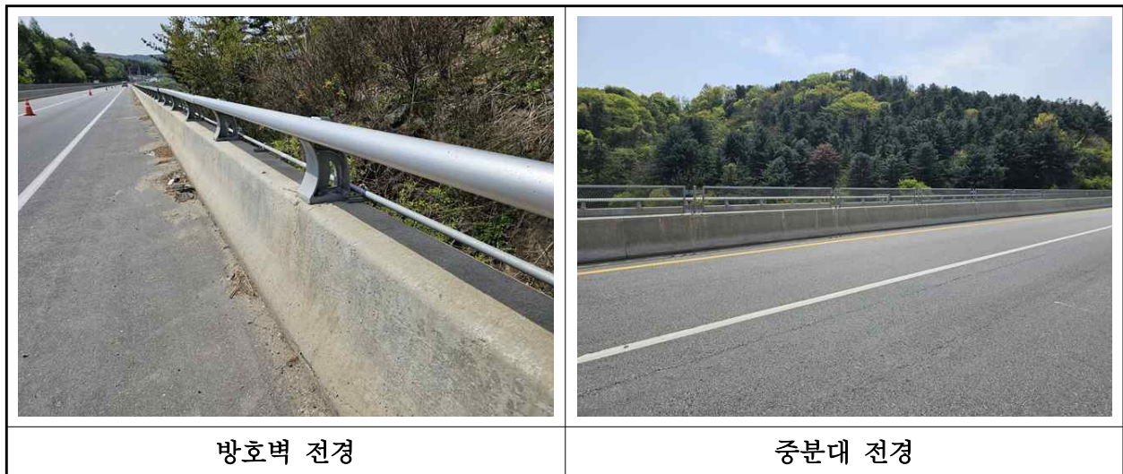
【사진 7.3.23】 방호벽 및 중앙분리대 전경
