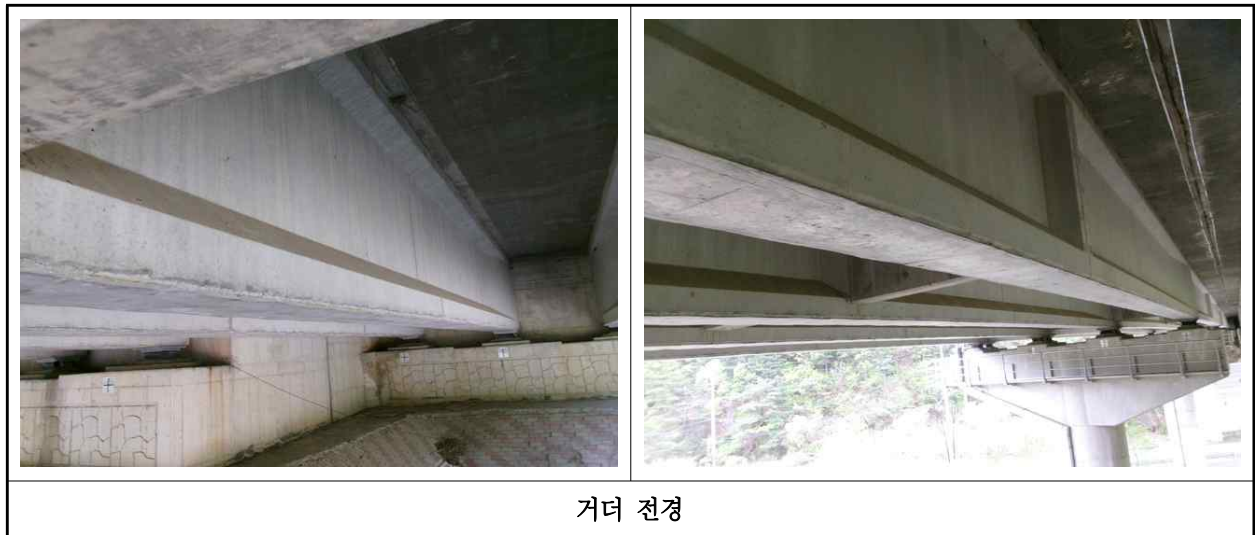
【사진 7.3.4】 거더 전경
