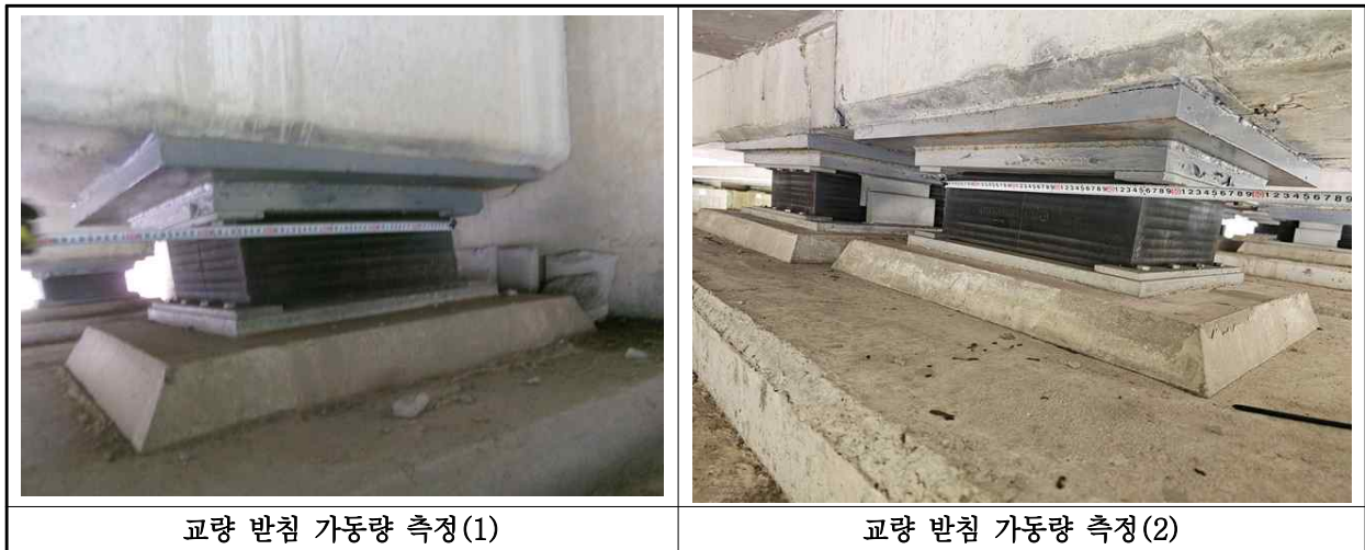
【사진 7.3.15】교량받침 이동량 측정
